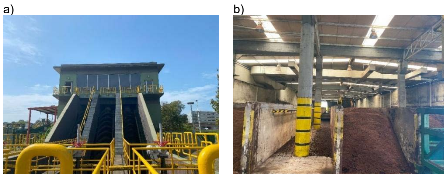
Figura 6.13 – a) Elevação inicial da ETAR de Parada, b) Edifício de compostagem de lamas
