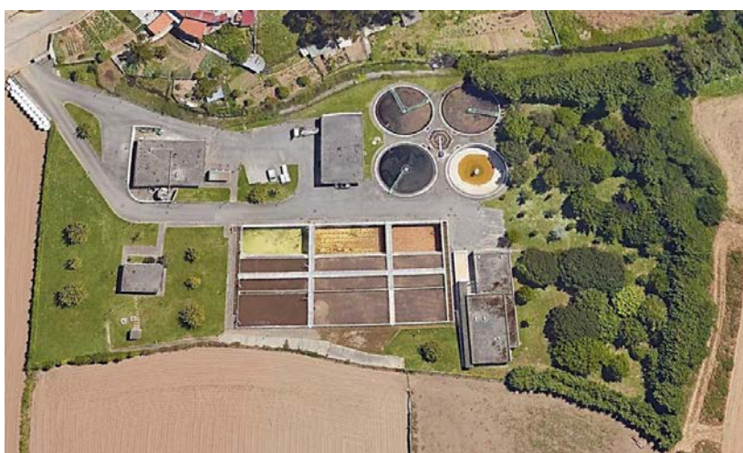
Figura 6.1 – Vista aérea da ETAR de Cambados.
