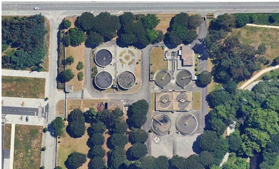
Figura 6.5 – Vista aérea da ETAR de Ponte de Moreira.
